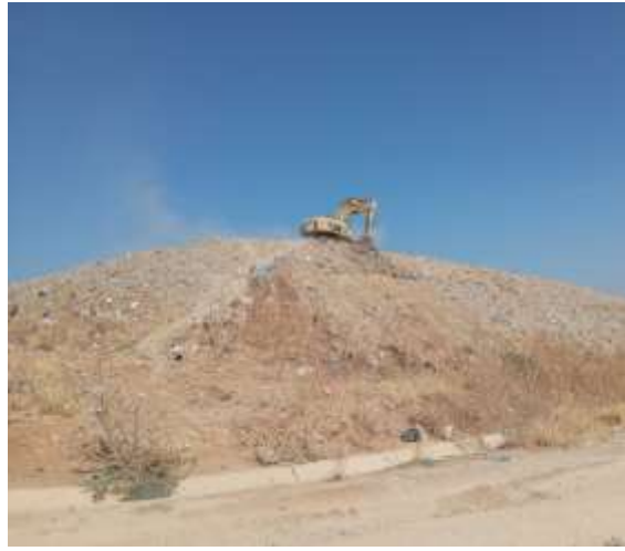
Afinado y peinado del talud de la macro celda 1.
