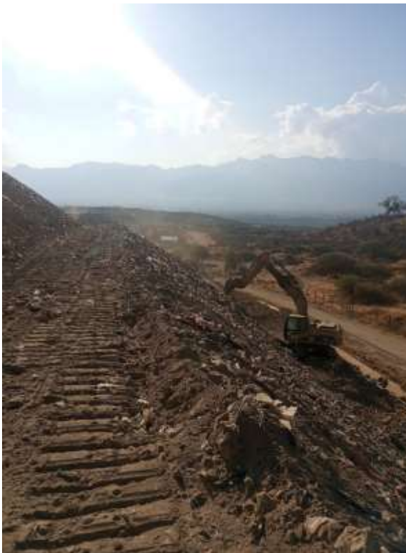
Afinado del talud intermedio de las macroceldas 1 y 2.
