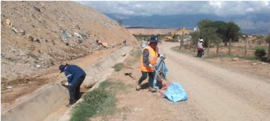
Limpieza de los canales de drenaje
